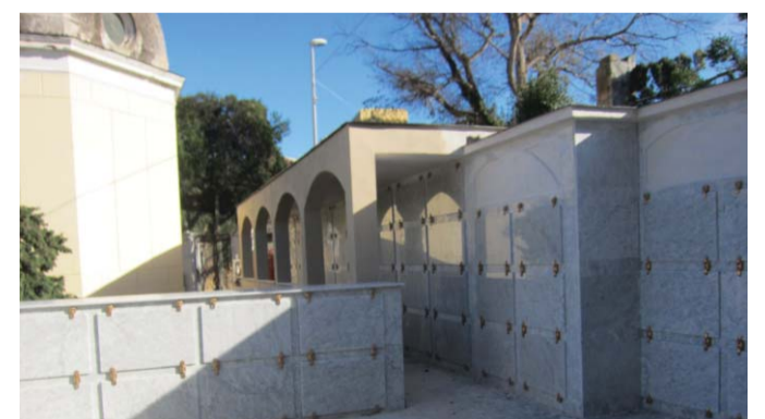
La realizzazione degli ossarini nel Cimitero isolano
