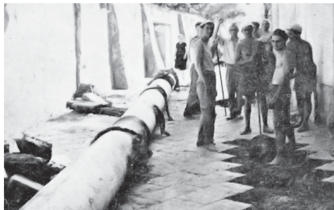
I lavori stradali per la costruzione dell'acquedotto
